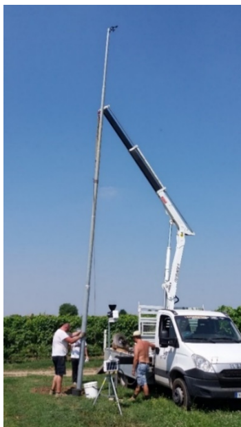
Fig. 10a Operazione di posa del palo anemometrico.
